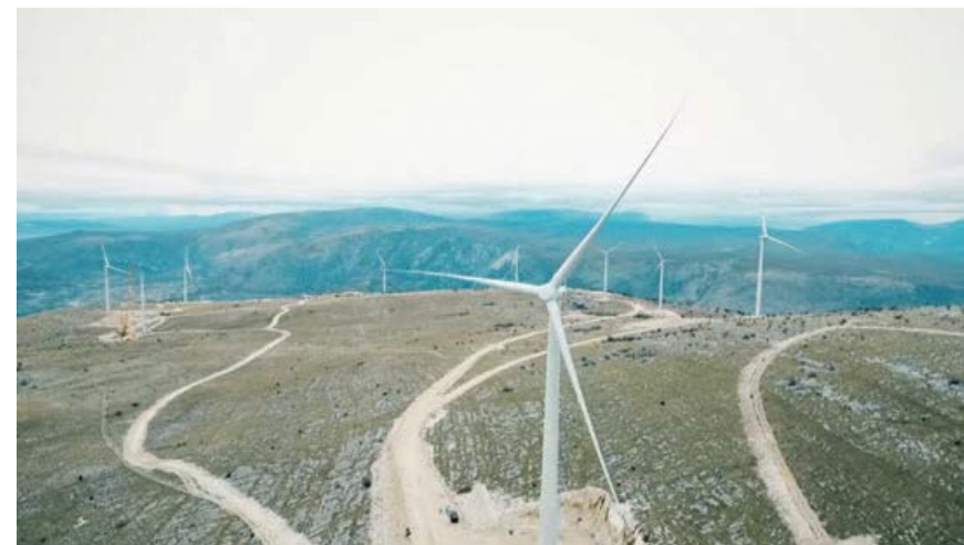
Slika 3. Vjetroelektrana Podveležje kod Mostara
