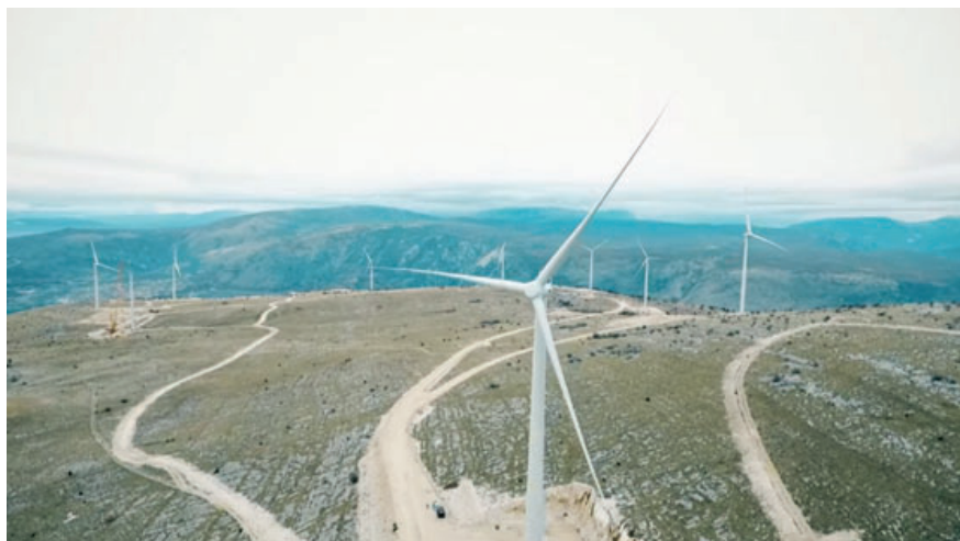
Slika 3. Vjetroelektrana Podveležje kod Mostara
